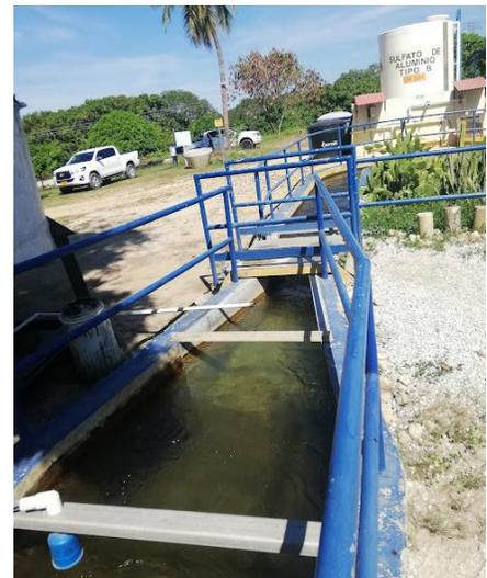
Se evidencia que posterior a la canaleta *Parshall*, el agua pasa por cámara de aquietamiento antes de llegar a los módulos de floculación-coagulación.
