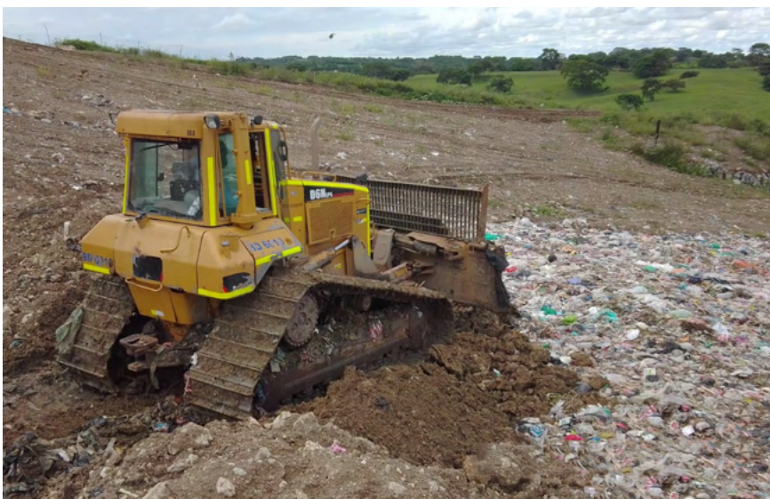
Foto: Cobertura térrica relleno sanitario el Oasis - Sucre
