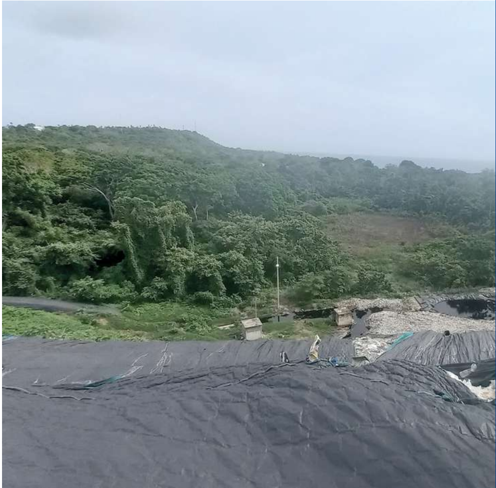
En Colombia, en el Relleno Sanitario Magic Garden de San Andrés, contamos con la Primera Planta de Valorización Energética de Residuos Sólidos Urbanos, la cual autogenera un 80 % de la energía que se requiere para incinerar residuos que permiten darle mayor vida útil al relleno sanitario.
